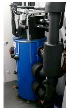
Direktverdampfer Kit Kaltwassererzeugung
