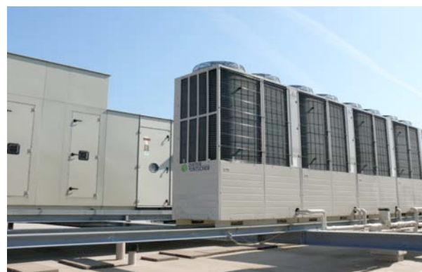
Direktverdampfer-Kit in Lüftungsanlage (links) MHI- Außengeräte FDCA (rechts)
