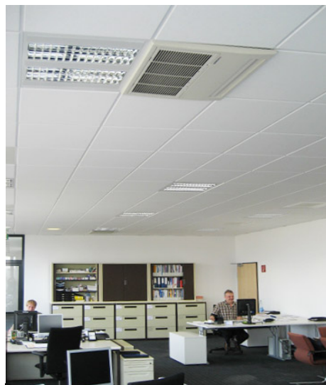
In Großraumbüro integrierte Deckenkassette
