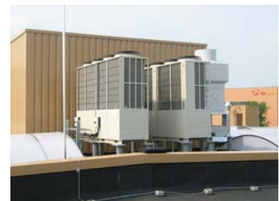
Aufstellung der Außengeräte
