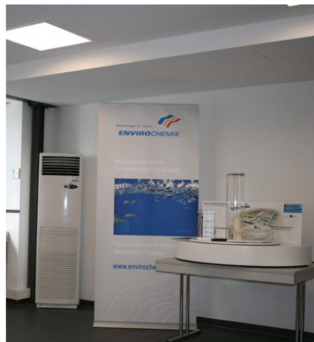
Klima-Tower im Ausstellungsraum
