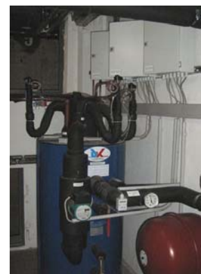
Wassermodul mit Direktverdampfer-Kit
