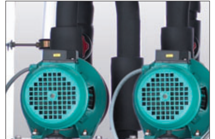
2 Hochdruckkreiselpumpen (Standby)
