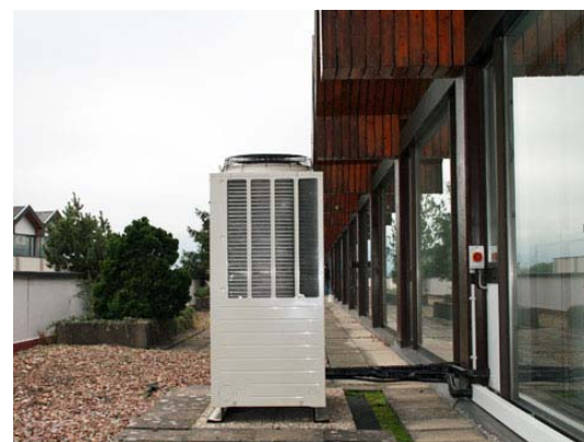
Installiertes Außengerät
