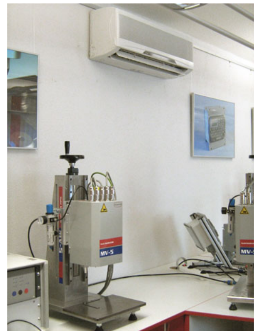
Innengerät im Montageraum
